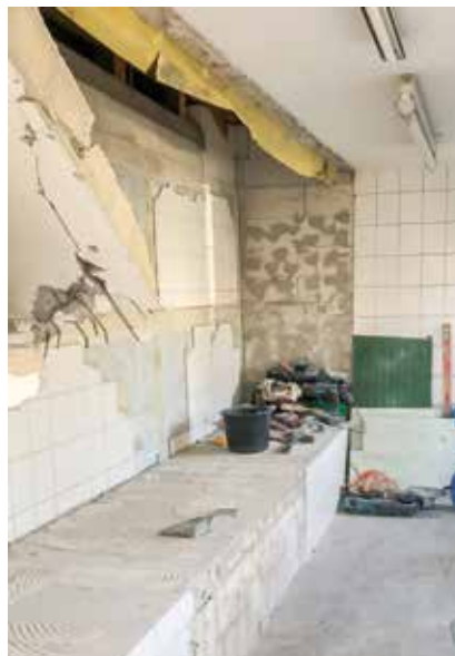
Abriss zur Hälfte geschafft.
