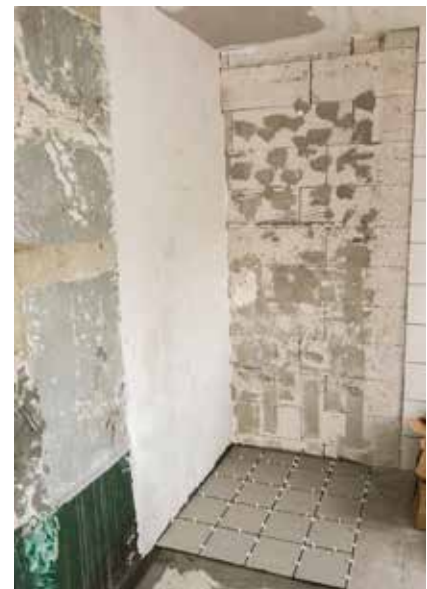
Mit neuer Decke und ersten Fliesen.
