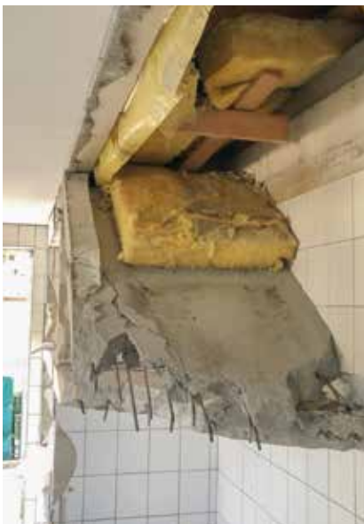
Nur Beton, keine Decke.
